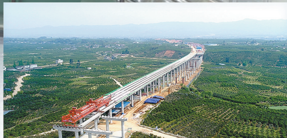
中铁建昆仑投资集团在四川投资建设的首个BOT项目——成都天府新机场及蒲江至都江堰高速公路项目。图为正在进行架梁施工的蒲都高速公路路基石特大桥。
