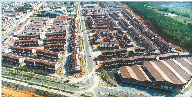
中铁建昆仑投资集团代表中国铁建在海南实施的最大投融资项目——海南国际旅游岛先行试验区项目。图为建设中的黎安小镇风貌。
