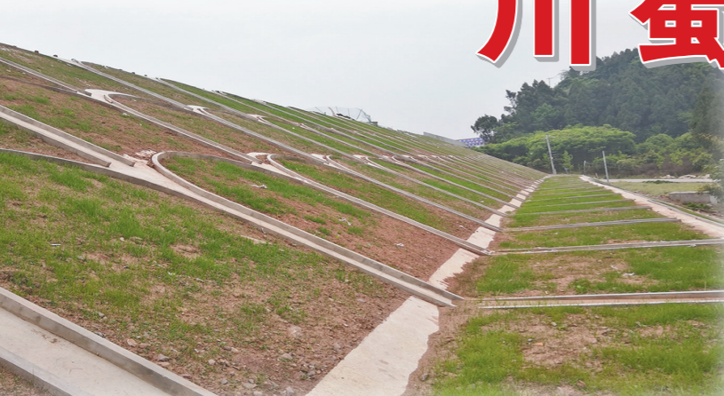
拱形骨架护坡完成。
