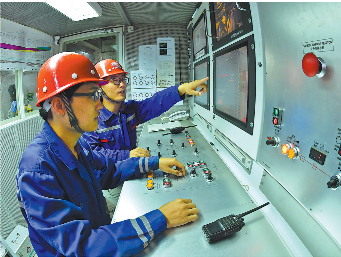
杭州市望江路过江隧道开挖直径11.75米,是浙江省重点工程。中铁十四局大盾构公司开展科技攻关,攻克圆砾地层等地质难题,目前完成一半掘进任务。图为操作手在操作盾构机。
