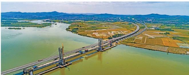
图为最大跨径248米的汉江特大桥,这是目前国内跨径最大的重载铁路斜拉桥。
