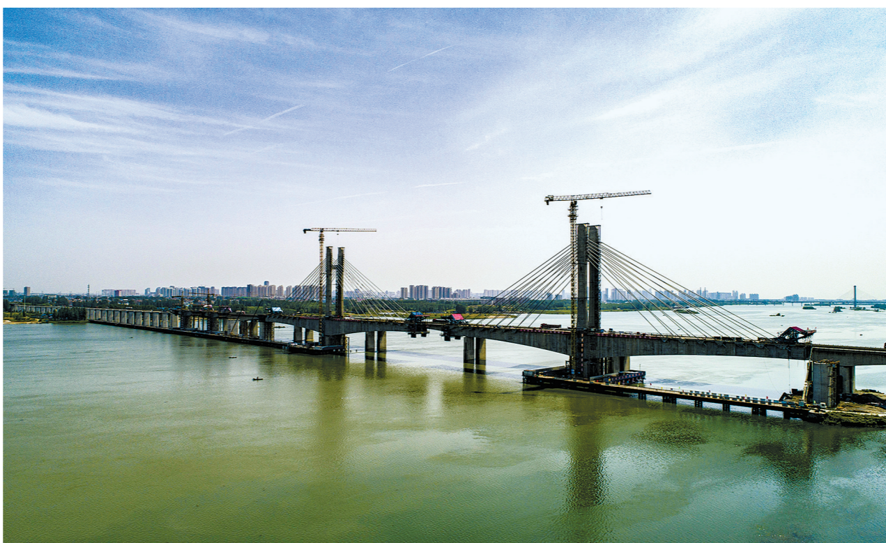
经过3年建设,由中铁十一局承建的蒙华铁路汉江特大桥主跨合龙在即。蒙华铁路汉江特大桥位于湖北省襄阳市,总长5242米,是蒙华铁路重点控制性工程之一。该桥共有18座水中桥墩,位于江面上的主桥为双塔斜拉桥,共5跨,最大跨径248米。图为汉江特大桥。
