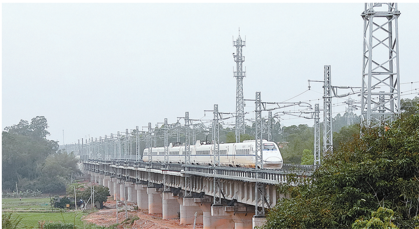
近日,江(门)湛(江)铁路联调联试开始以运营速度试跑,预计于6月底正式开通运营。全长354.852公里的江湛铁路,东接广珠城际铁路江门站,西至湛江西站,设计时速200公里,是我国沿海快速铁路大通道的重要组成部分。该线路开通后,将结束粤西三市(湛江、茂名、阳江)不通高铁的历史,广州至湛江的铁路运行时间将由现在的8个小时缩短至3个小时左右。图为联调联试列车正在通过由中铁二十三局承建的玉山特大桥。李亚萍 摄
