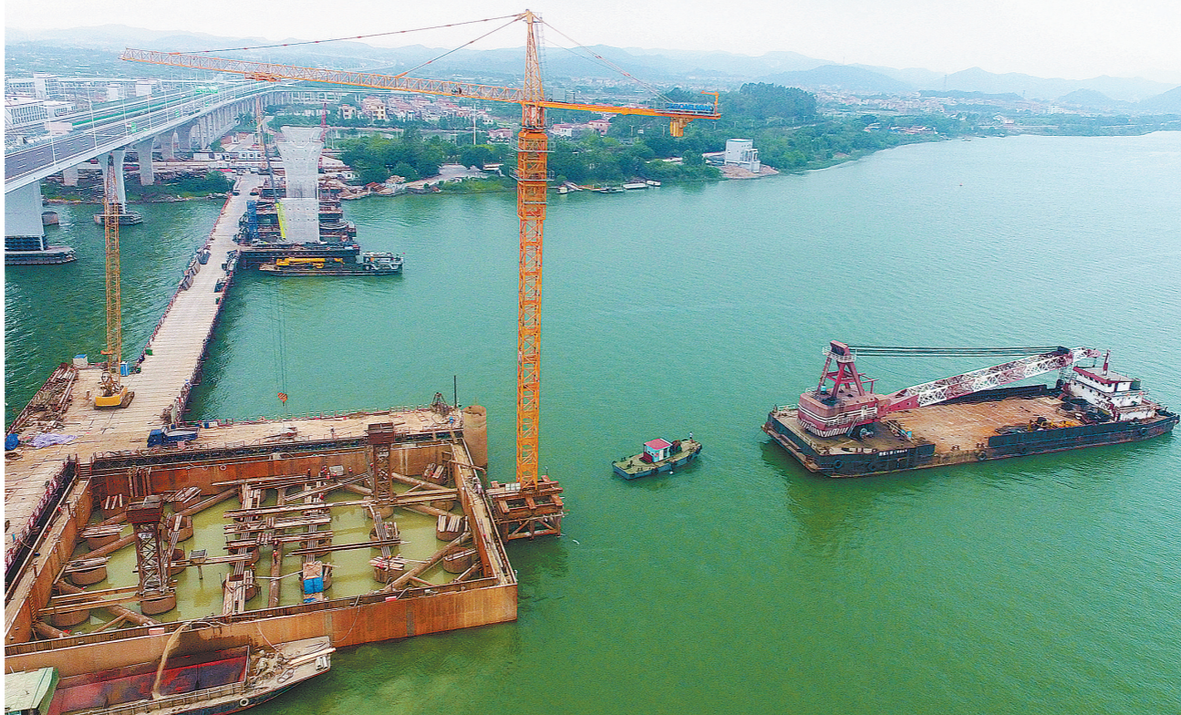
中铁十一局一公司在南沙港铁路跨西江斜拉桥施工中,充分利用BIM技术高度信息化的优势,通过建立3D动态管理平台,实时对复杂水文地质、深基坑等高风险工序和安全隐患点进行动态管理,预防安全事故的发生。据悉,该桥主跨600米,跨度在同类铁路斜拉桥中居世界第一。图为建设者正在进行主墩承台双臂钢围堰施工。 闵辉摄
