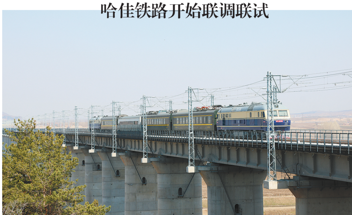
近日,中铁二十三局参建的哈尔滨至佳木斯铁路开始联调联试。该铁路全长343公里,设计时速200公里,是我国高寒地区最长快速铁路,将于8月底正式开通运营。图为检测列车通过哈佳铁路牡丹江特大桥。李亚萍 摄
