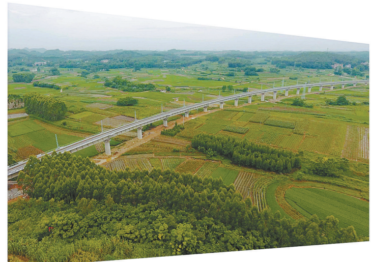
坛深左线特大桥。
