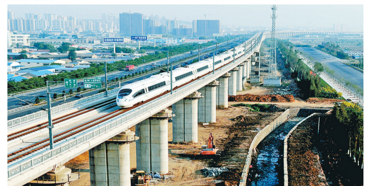
图为哈大高铁金州湾二号特大桥。
