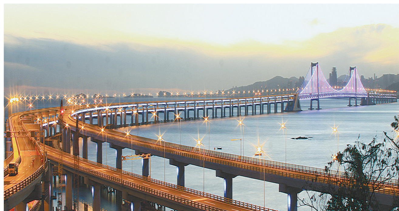
▲大连南部滨海大道跨海大桥。
