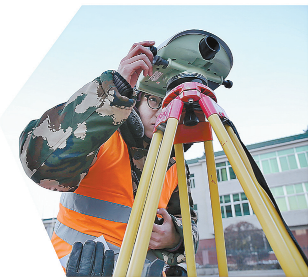
长春地铁项目部技术人员使用电子水准仪进行地表沉降观测。
