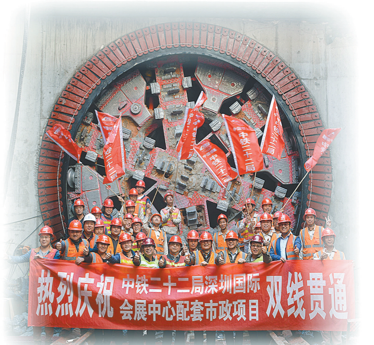
深圳国际会展中心配套市政项目双线贯通
