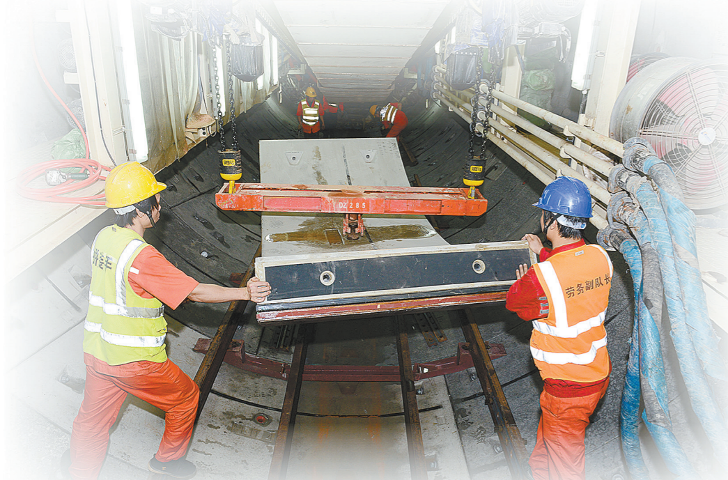
盾构区间操作人员进行管片安装
