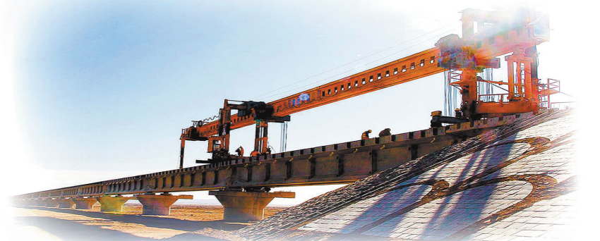
铺架通过格库铁路茫崖湖3号大桥
