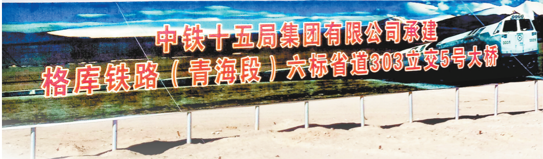
铺架通过省道303立交5号大桥
