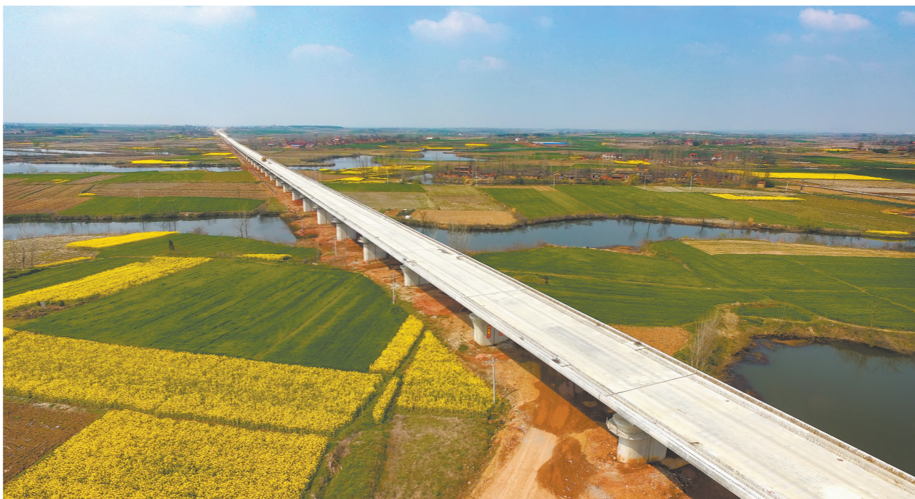
近日,由中铁十一局承建的汉十铁路5标段780片箱梁全部架设完成,为下一步无缝轨道施工奠定了坚实基础。汉十铁路全长391.5公里,不仅是湖北省内连通武汉、襄阳、十堰、随州的重要区域性快速铁路,也是沟通华中与西北地区、东南沿海的国家战略大通道。图为施工中的汉十铁路英河特大桥。金伟摄
