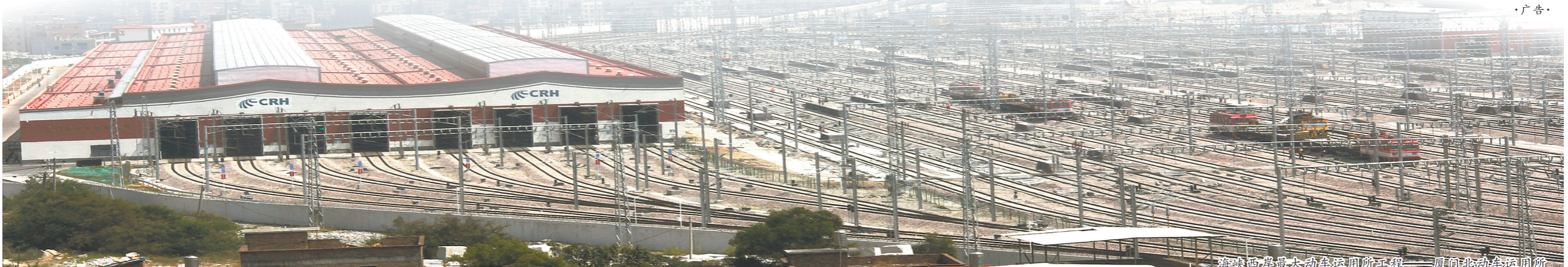
海峡西岸最大动车运用所工程——厦门北动车运用所
