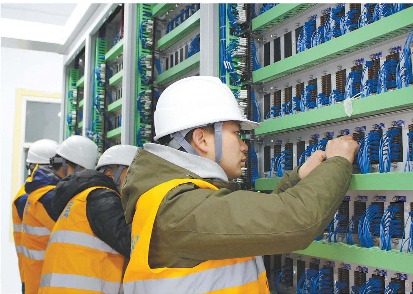
中国铁建电气化局济青高铁“四电”2标项目部职工春节期间坚持施工,按照济青公司提出的“通信、信号工程打造‘绣花工程’”的高标准要求,日前顺利通过了业主对济青高铁通信、信号首件工程评估验收。图为信号专业职工在淄博北站进行组合布线。 齐晓景 摄
