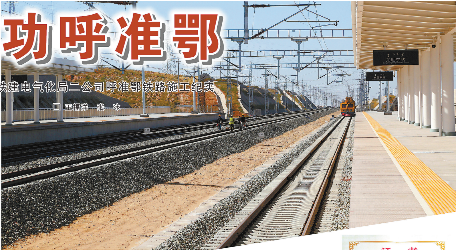
东胜东站硬横梁和雨棚工程
