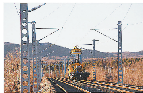
滨洲项目建设者正在进行接触网施工 赵迪 摄
