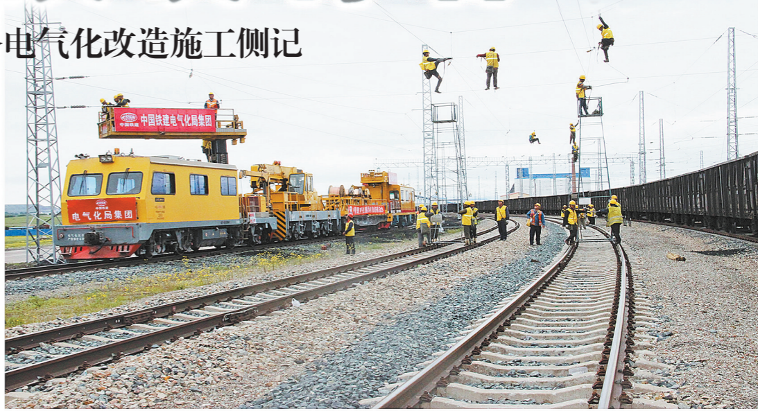
滨洲项目部“百日会战”施工现场
