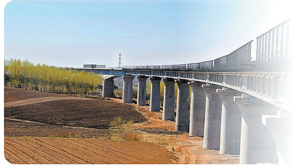
跨哈同高速公路特大桥。
