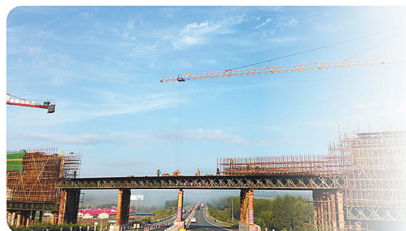
连续梁满堂支架。
