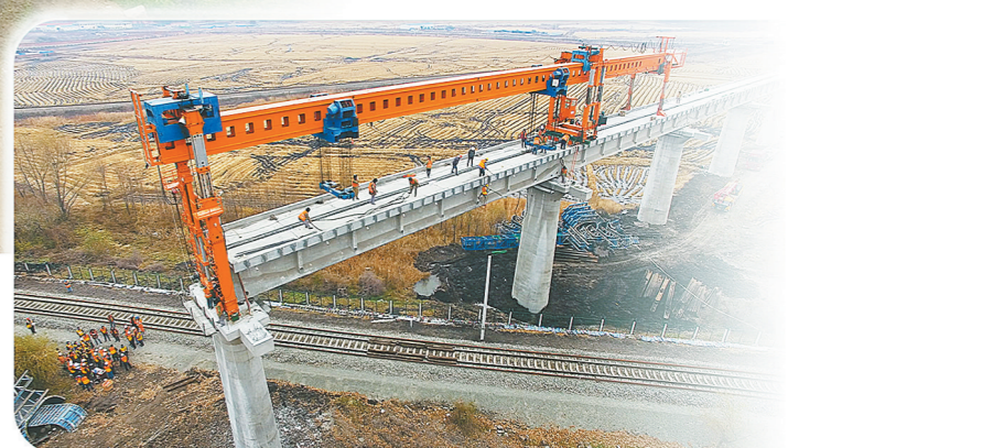
成高子特大桥跨滨绥铁路下行线T梁架设。
