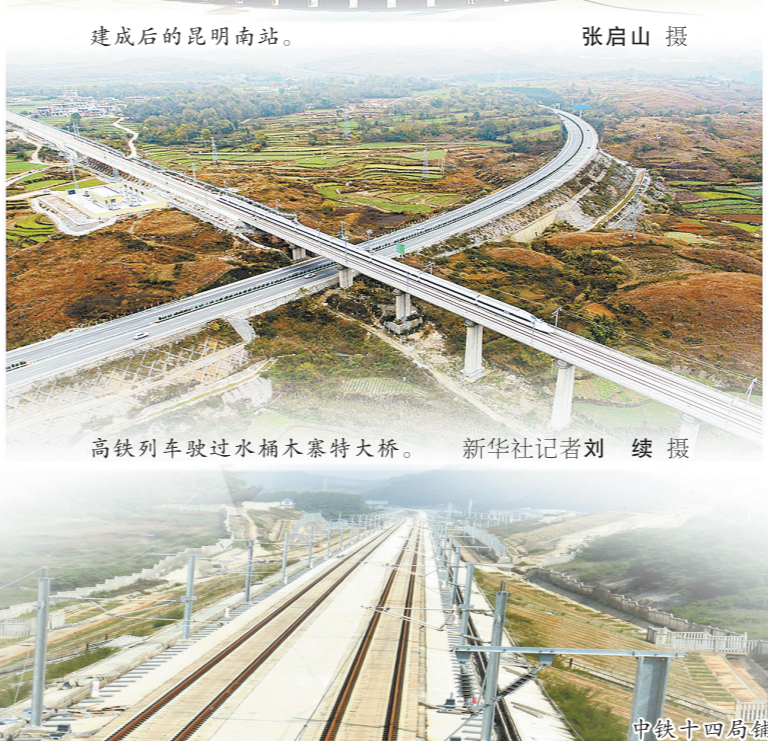
高铁列车驶过水桶寨特大桥。 新华社记者刘 续 摄
