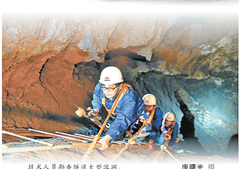
技术人员勘察隧道大型溶洞。 庞曙光 摄
