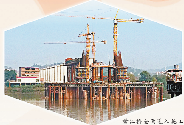
赣江桥全面进入施工。
