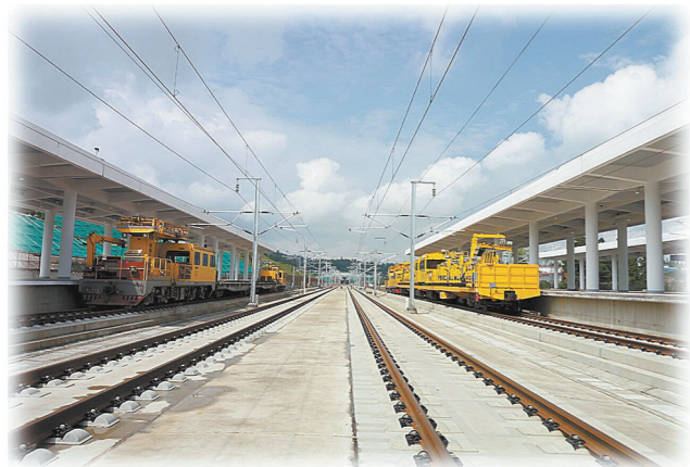
车站接触网施工
