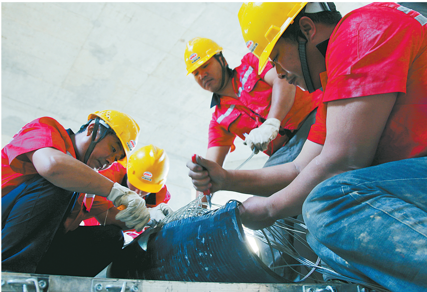
在佛(山)(东)莞城际铁路施工中,中铁二十局五公司通过技术创新,在珠三角盾构施工中首次采用连续皮带输送机出渣技术,较传统出渣方式提高了50%以上的工效。图为工人们正在进行输送带接口连接。 唐相彦 摄
