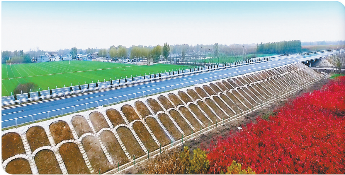
已建成的路基工程。
