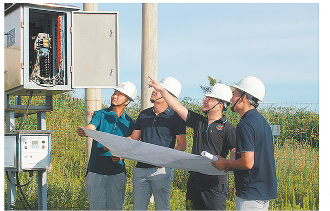
电气化公司总经理助理、铜玉项目经理王再伟(右二)在现场指挥真空断路器的安装。
