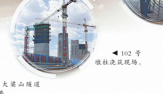
▲102号墩柱浇筑现场。
