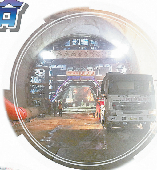
▲施工中的大梁山隧道。
