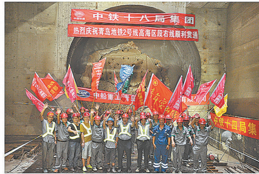
2016年8月3日,建设者们欢呼中铁十八局隧道公司承建的青岛地铁2号线高海区段右线贯通。 刘建平 摄
