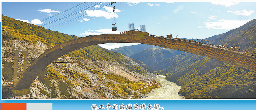
施工中的玻璃沟特大桥。
