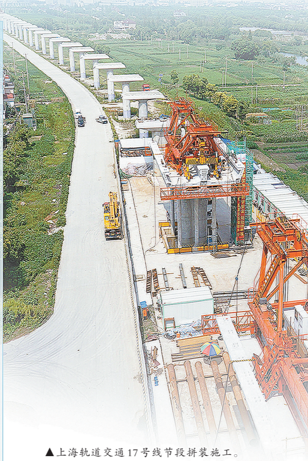
▲上海轨道交通17号线节点拼装施工。
