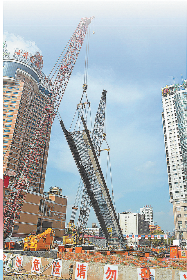
合肥地铁大东门车站第一幅地下连续墙混凝土浇筑。
