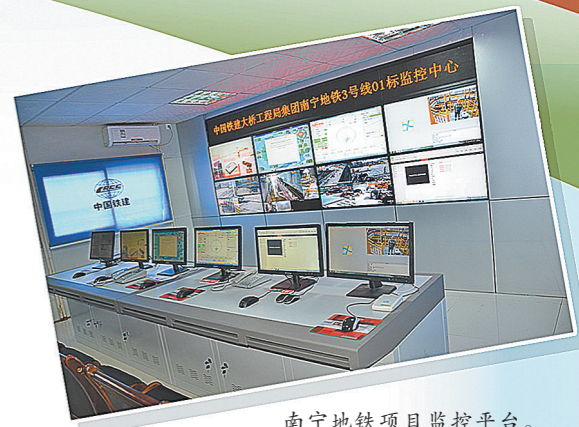
南宁地铁项目监控平台。
