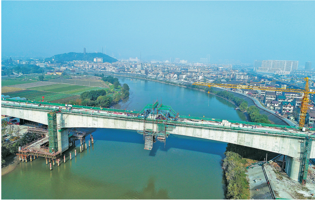
12月7日,由中铁二十四局浙江公司施工的杭(州)黄(山)铁路浦阳江特大桥合龙。该桥连续梁主跨为135米,是全线跨度最大、制约杭黄铁路工期的控制性工程。图为连续梁跨合龙施工现场。朱峰 摄
