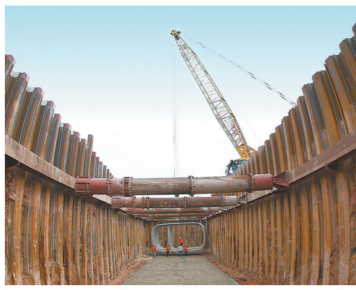
全线下放第一片预制管廊涵管。
