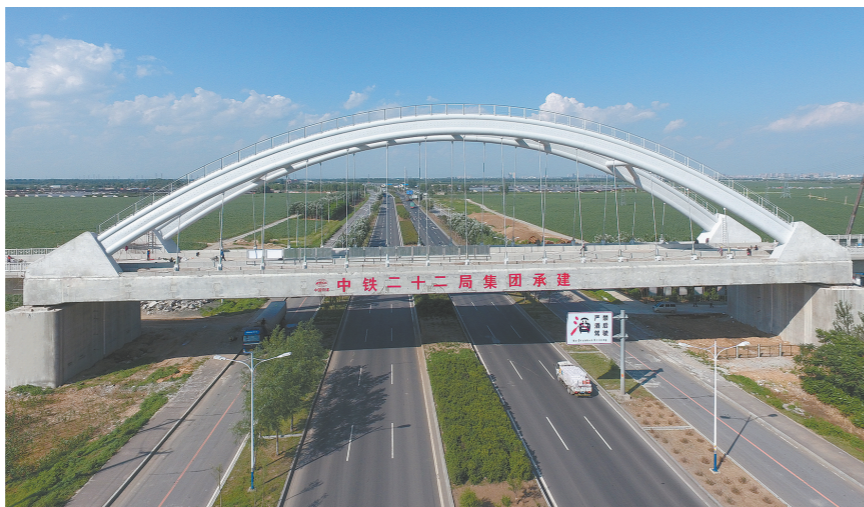
全线首家完成的100米筒支拱
