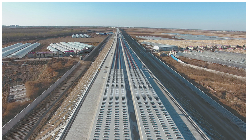
被称为京沈客专辽宁段第一窗口的沈阳西站路基
