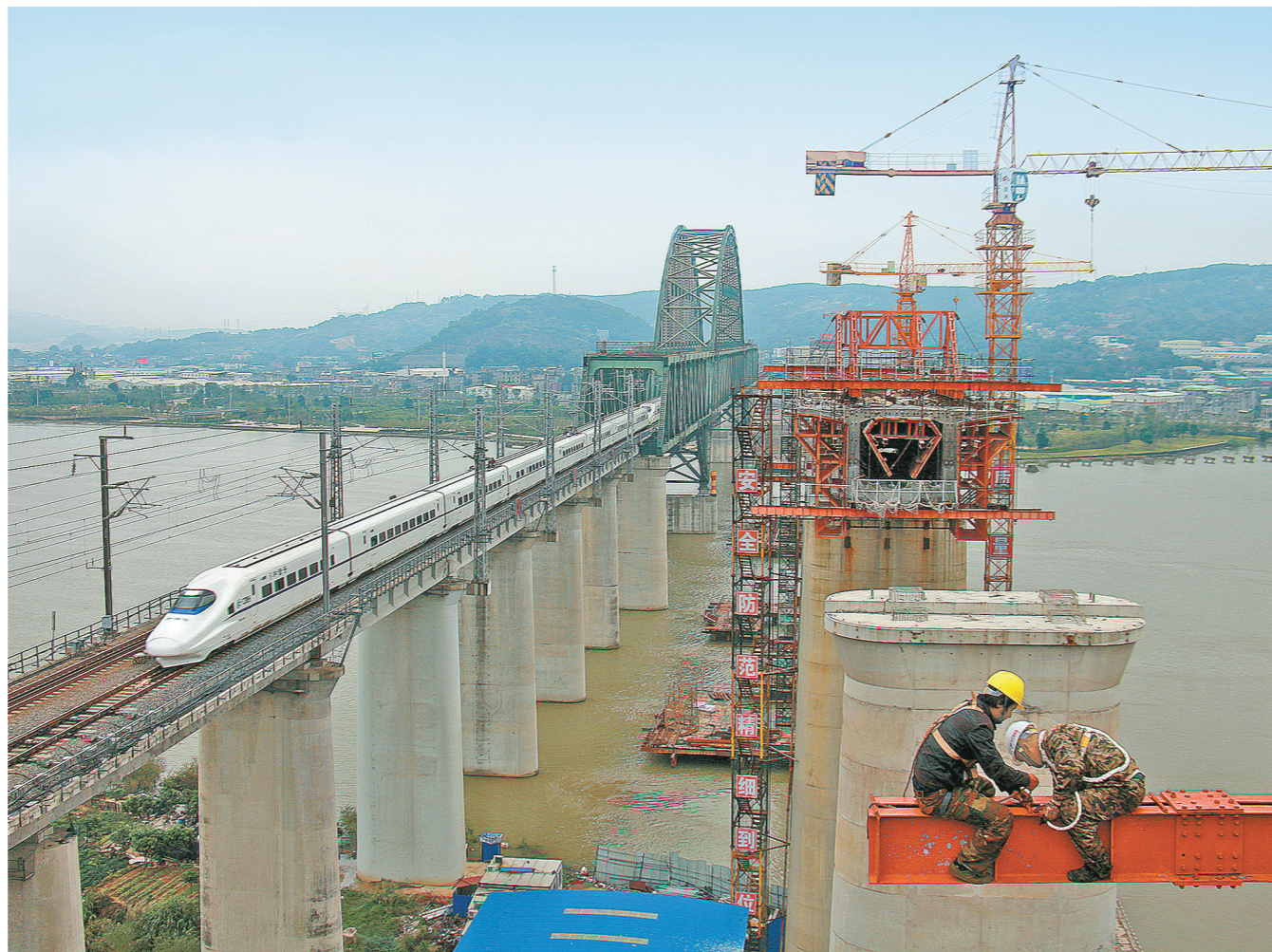
中铁十八局承建的福州(平)潭)铁路闽江特大桥全长2563米,紧邻福厦铁路闽江特大桥。二公司项目部注重安全防护,确保施工现场安全作业。图为12月1日,施工人员在桥梁施工中进行安全防护检查。 本报记者伍振摄
