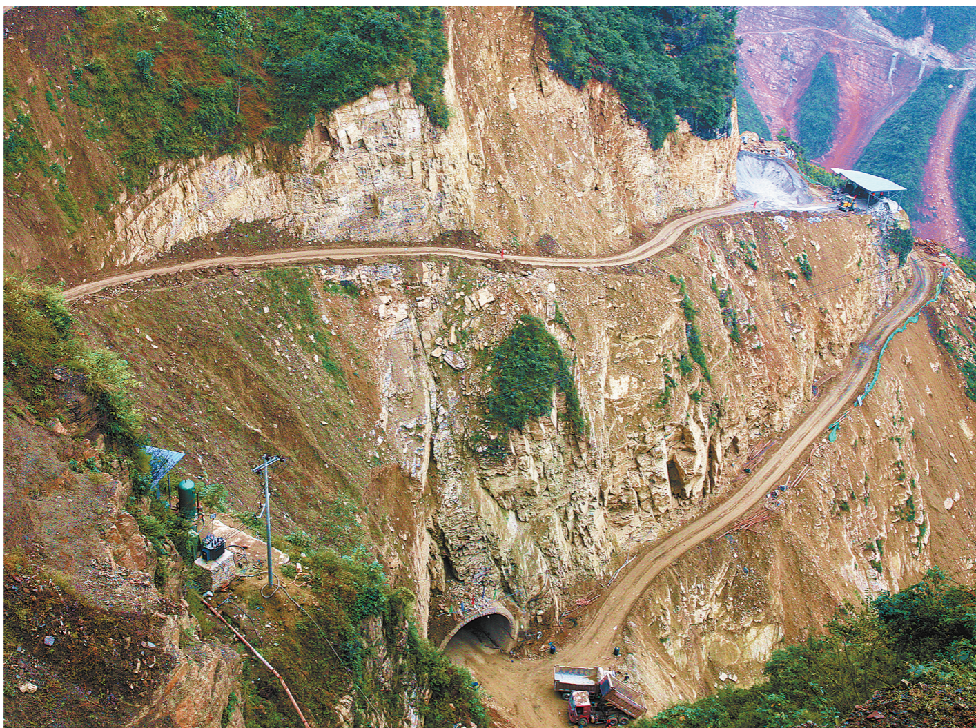
中铁十六局承建的云南省昭永公路S20标段，位于青藏高原和云贵高原向四川盆地过渡的斜坡地带，重峦叠障，峰高谷深。为尽早实现当地百姓的“公路梦”，参建人员如蜘蛛侠一样，登高攀岩进行施工。图为现场作业情况。 檀少贵 摄
