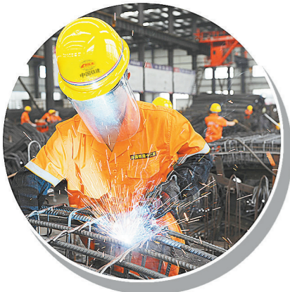
图为混凝土分公司员工在车间进行钢筋笼加工。
