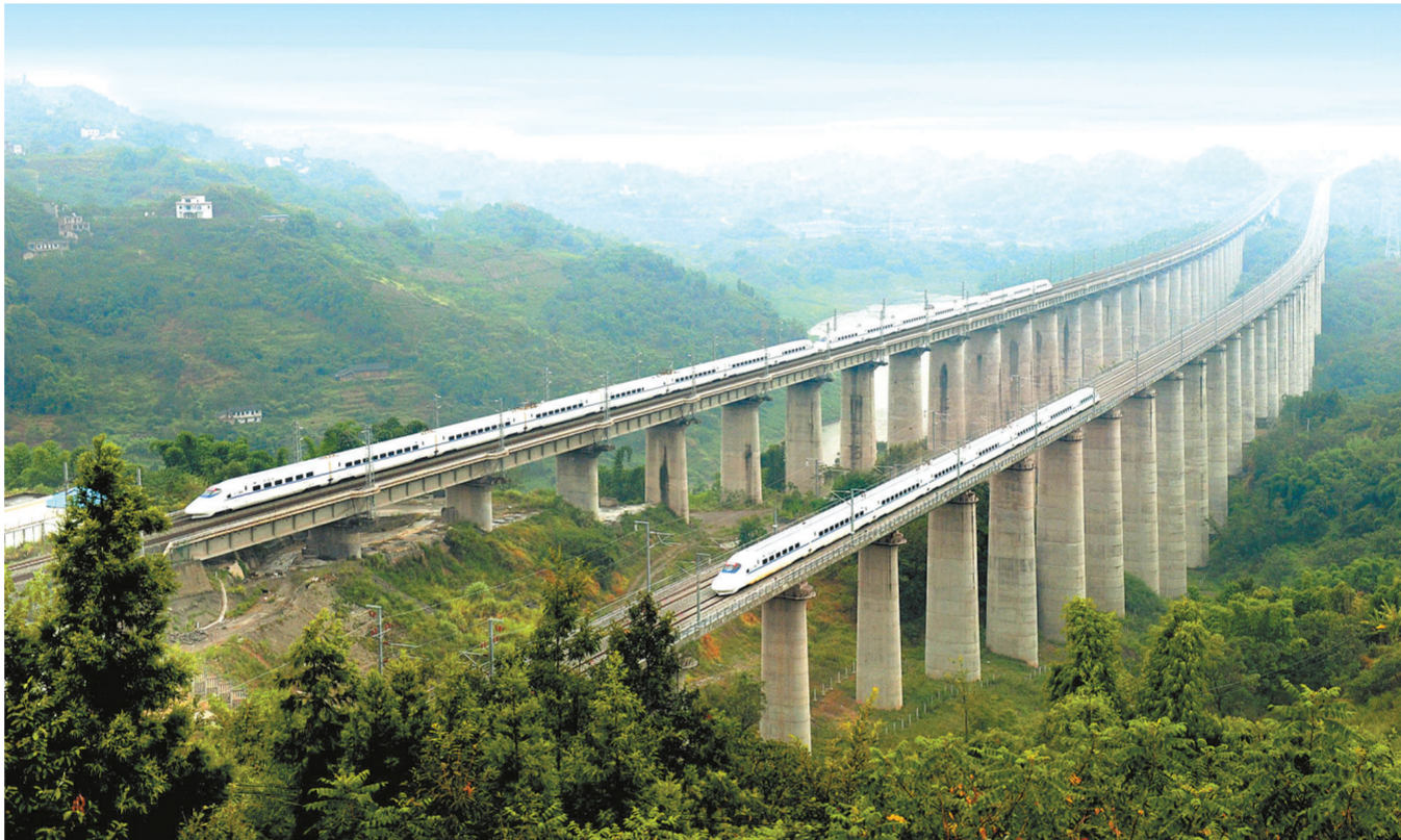
11月28日,由中铁十二局承建的新建重庆至万州高速铁路建成通车。该线全长247公里,设计时速250公里,跨河川,越峻岭,使重庆到万州仅需1个小时,通车后将拉动沿线经济起到积极促进作用。图为动车飞驰在由中铁十二局承建的御临河特大桥上。
