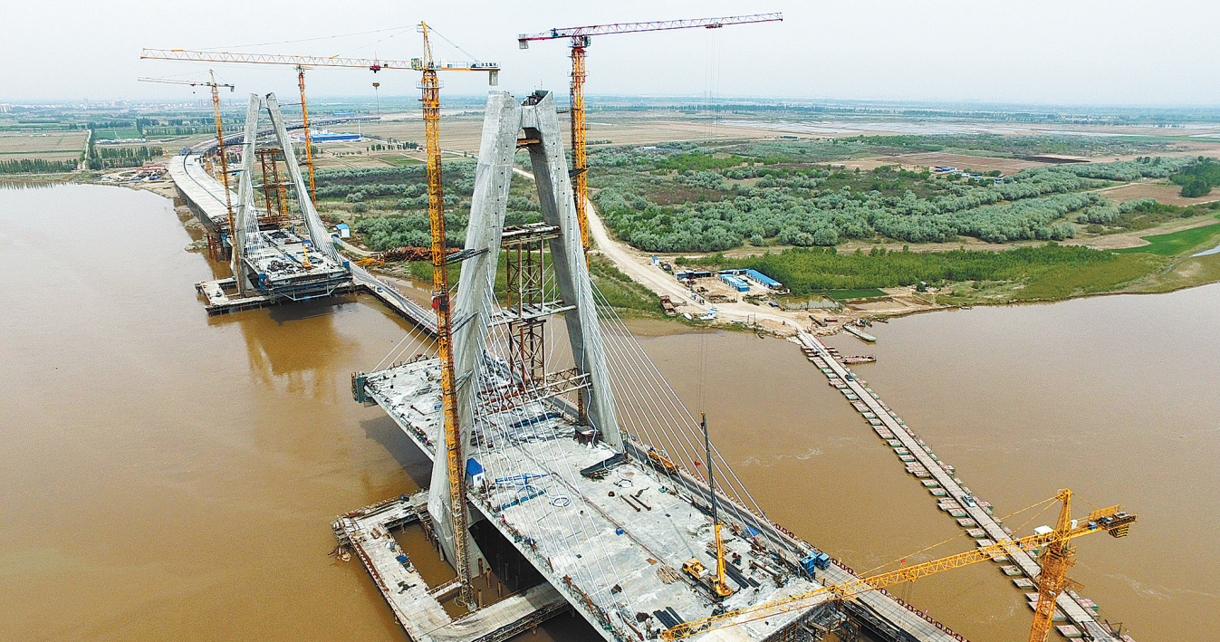
永宁黄河公路特大桥是宁夏第一座跨黄河双塔双索面斜拉桥,大桥全长3743.37米,主塔高102.15米。中铁十六局五公司在施工中开展科技攻关,采用粘滞阻尼器+弹性索抗震防位移等施工技术,攻克了大体积混凝土等施工难题,进一步提升了桥梁施工品牌影响力。图为近日正在施工的永宁黄河公路特大桥。 许鹏健 摄
