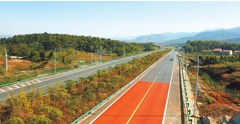
▲黄(石)咸(宁)高速公路路基工程
