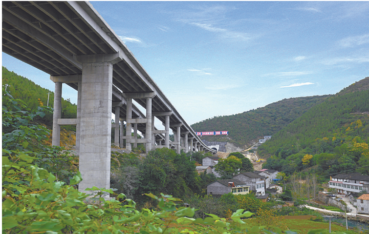
▲隰(县)十(堰)高速公路柳泉沟大桥
