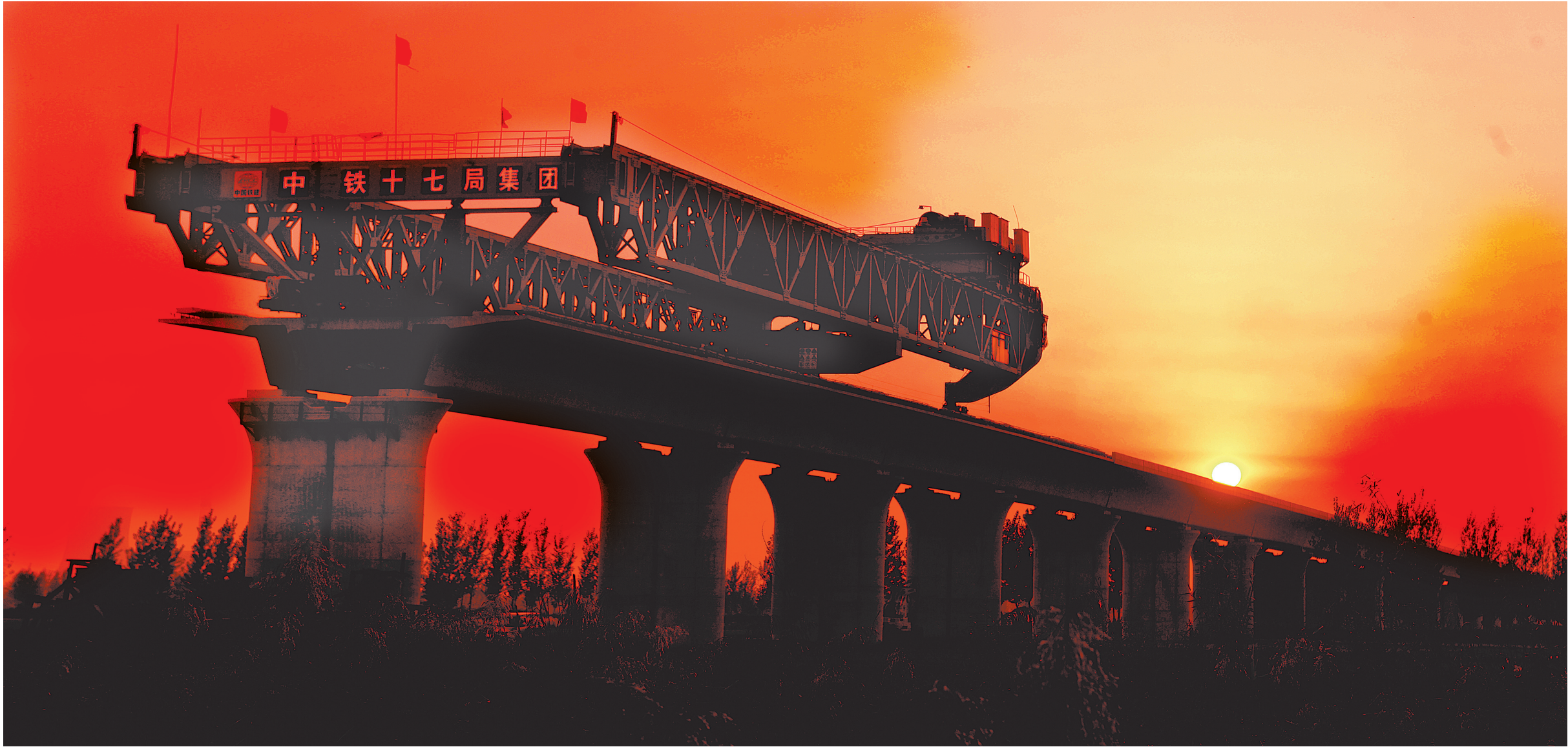
▲郑(州)徐(州)客专项目架梁现场
