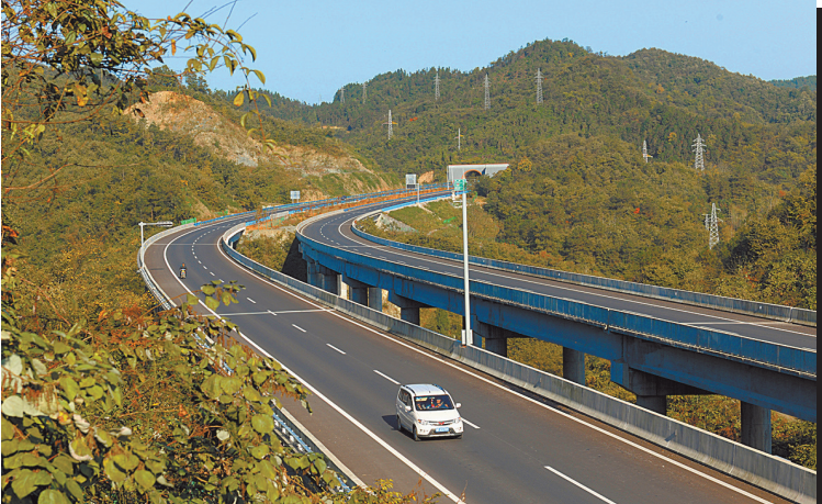
▲谷(城)竹(溪)高速公路潭口水库特大桥
