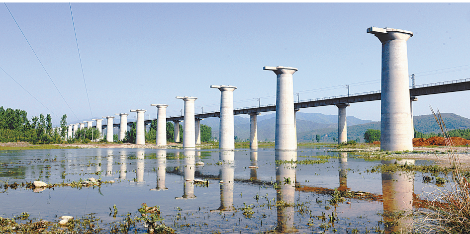
▲谷(城)竹(溪)高速公路潭口水库特大桥
