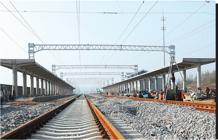
▲山西中南部铁路通道20标沂水西站
