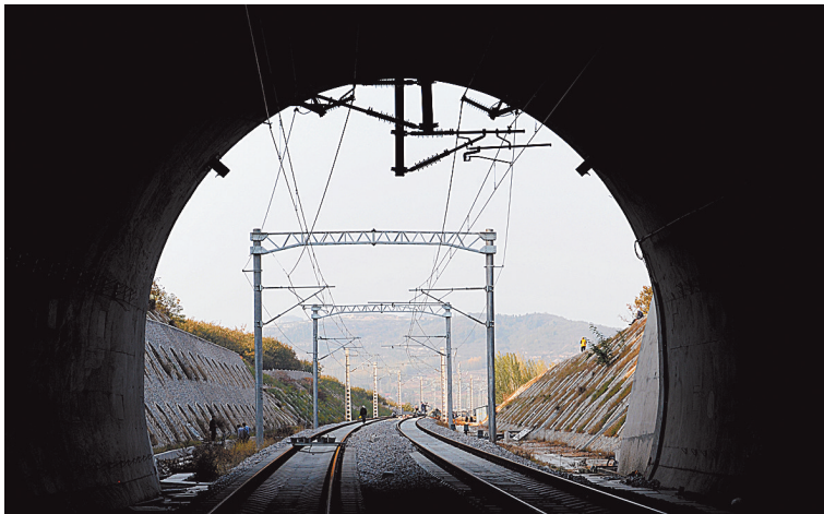
▲山西中南部铁路通道20标韩家旺隧道
