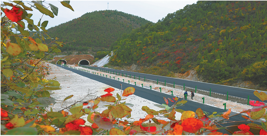
▲隰(县)十(堰)高速公路路基工程
