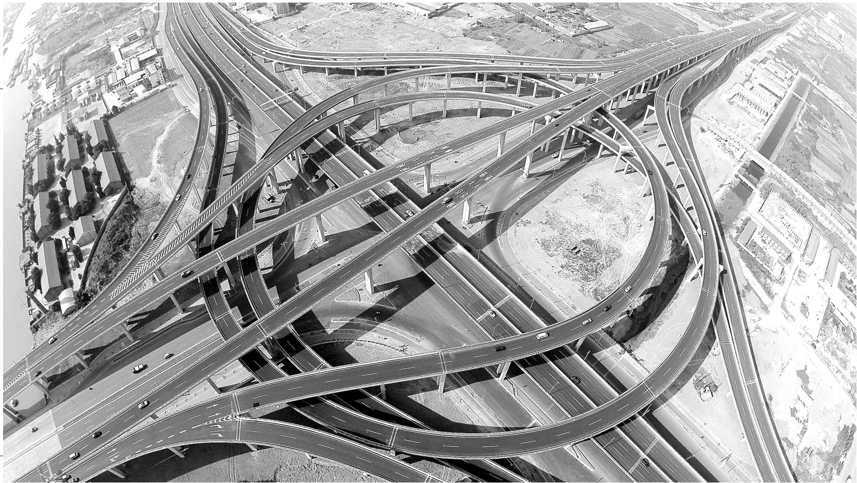
二十四局集团路桥公司在江苏省南通市江海大道东段A标施工中,采用达到国际先进水平的超长度混凝土连续梁等比例调坡整体顶升技术,确保安全施工,工程创优。图为近日通车的东海大道东段A标互通立交通车。
