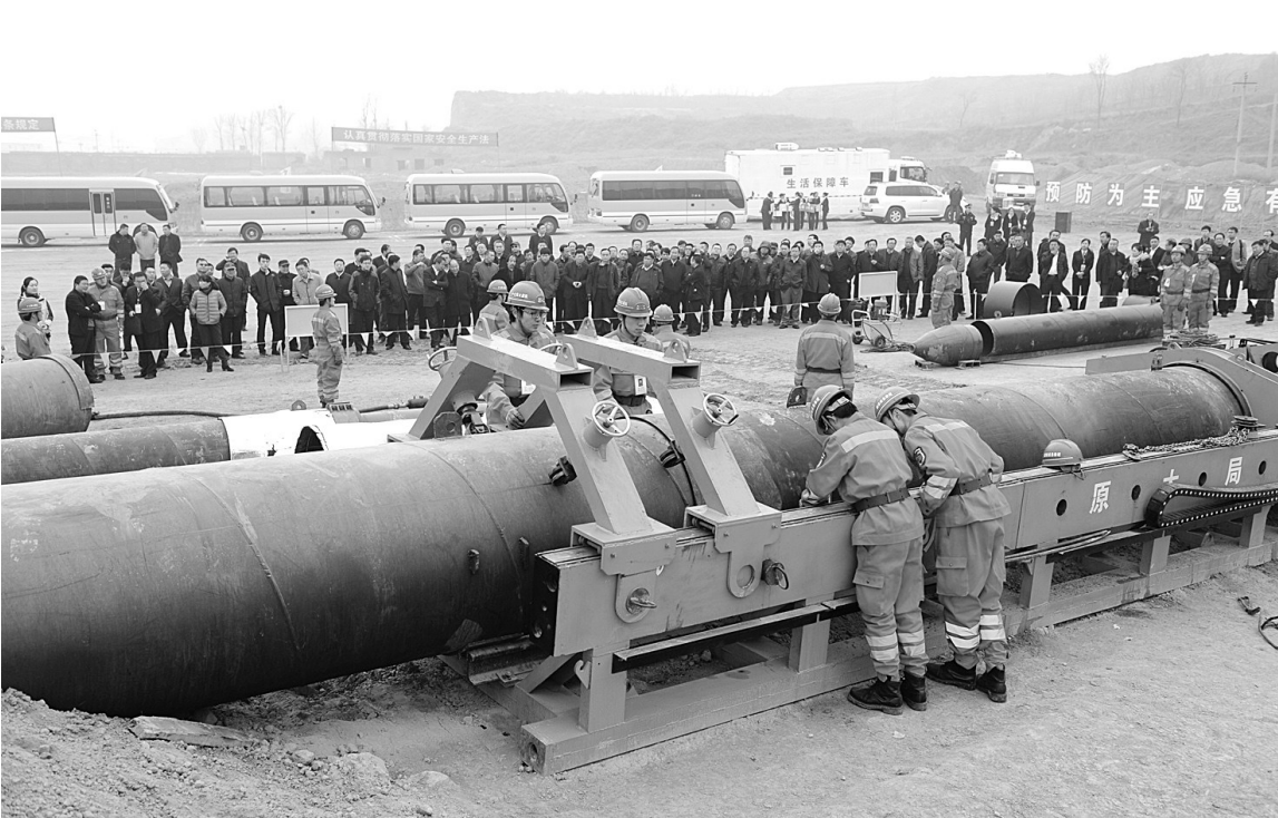
图为十七局集团应急救援队隧道顶管救援演练现场。周福荣 摄
