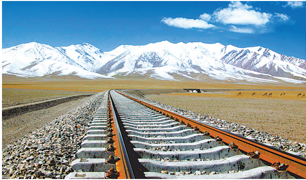
由中国铁建建成的青藏铁路攻克了高原铁路施工的三大世界难题。刘建国 摄
