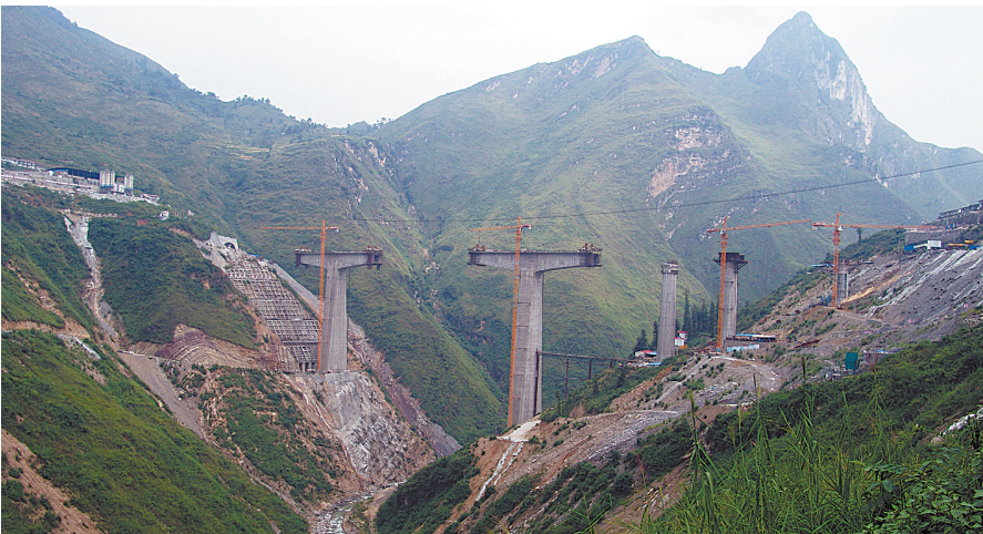
岔河大桥连续梁施工
