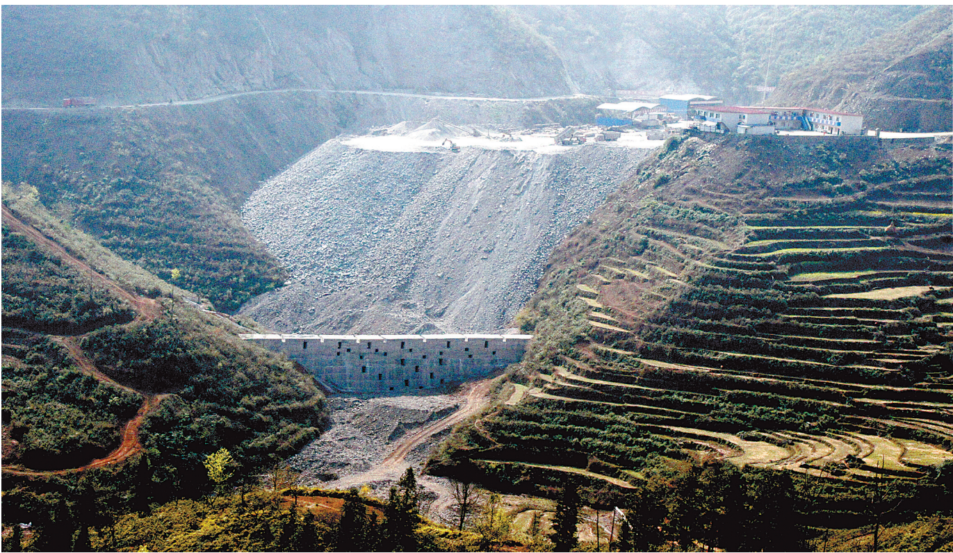
何家寨隧道横洞弃渣场环保坝
