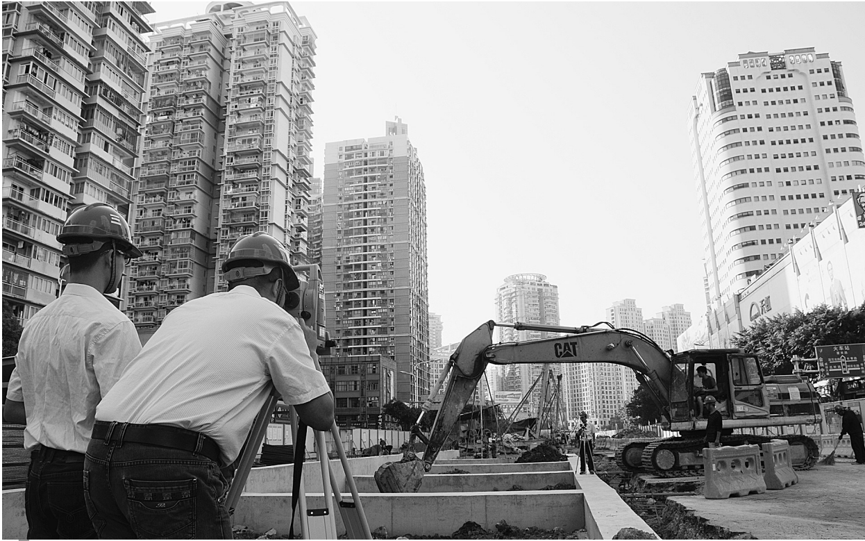
十八局集团一公司承建的厦门地铁1号线吕厝站处于厦门闹市区。项目部对现场围挡实施连续封闭,南侧采取增高围墙、设置屏蔽等措施,减少施工带来的噪音污染。图为吕厝站施工现场。
