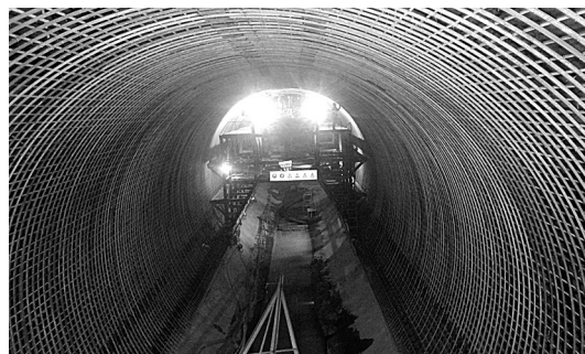
3号引水隧洞钢筋绑扎
