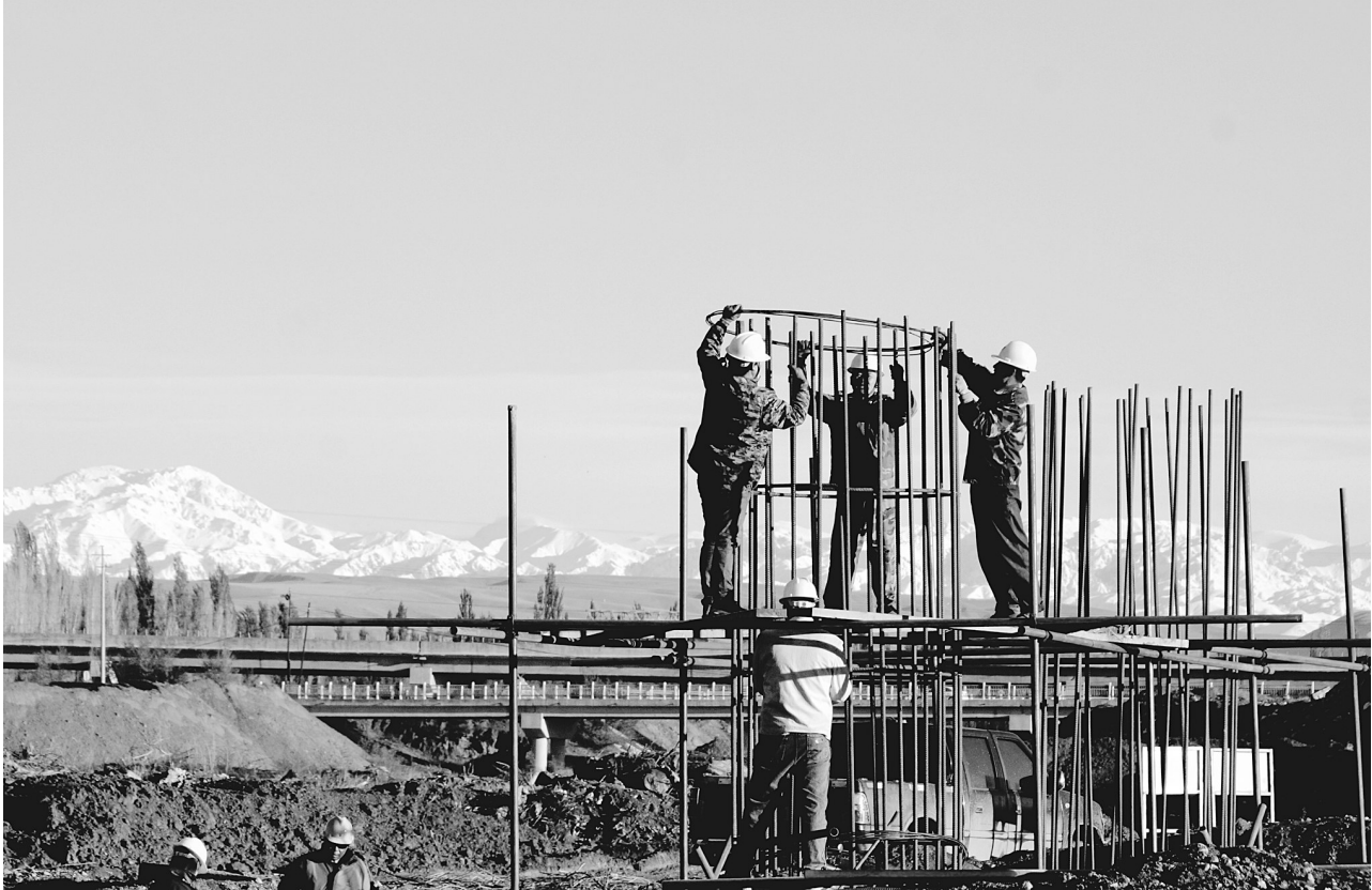
二十一局集团承建的新疆伊犁河北岸干渠5标段,全长18.1公里,位于新疆伊宁市。伊犁河北岸干渠工程是伊犁重点灌区建设的骨干工程,建成后将极大地改善伊犁州农牧业和林业灌溉渠网,提升生态改良基础条件。图为皮里青渡槽墩柱施工。
