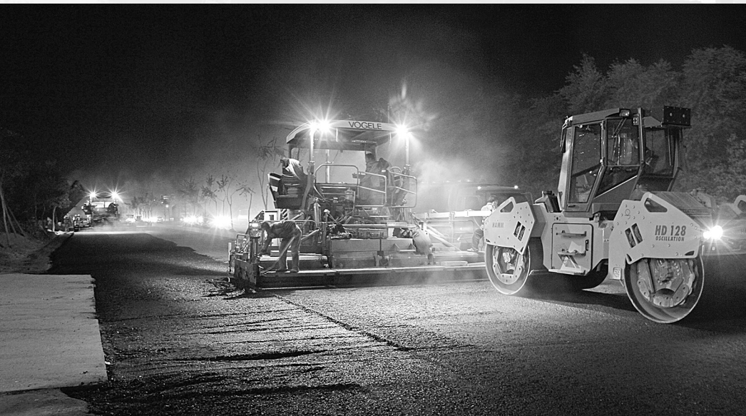
沥青路面夜间施工
