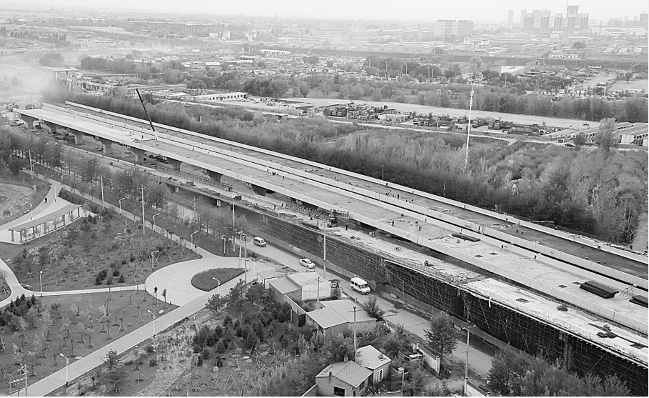
鄂尔多斯主线桥施工现场
