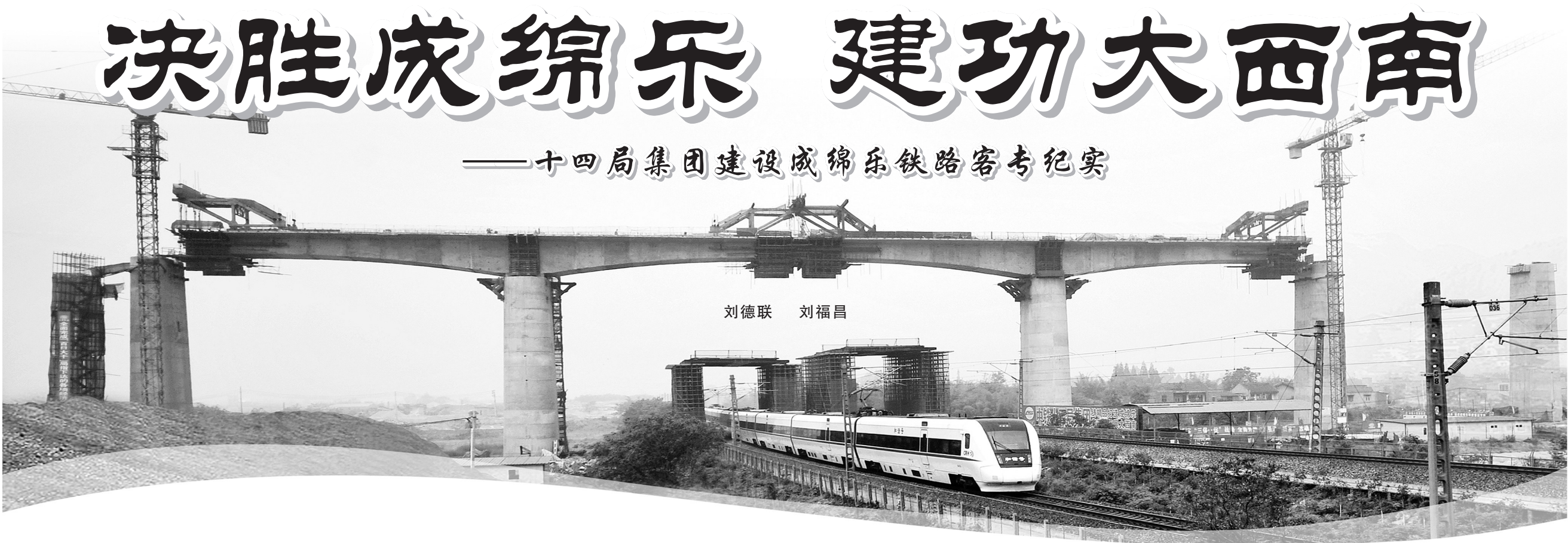
▲跨成渝铁路悬灌梁
