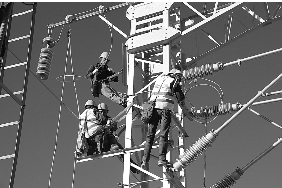
二十二局集团在敦格铁路建设中,以标准化管理为抓手,狠抓安全管理,加强安全培训,目前未发生一起等级安全质量事故。图为员工正在进行高空作业。 郭红摄
