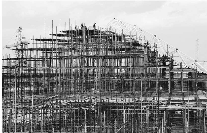
屋面网壳安装
