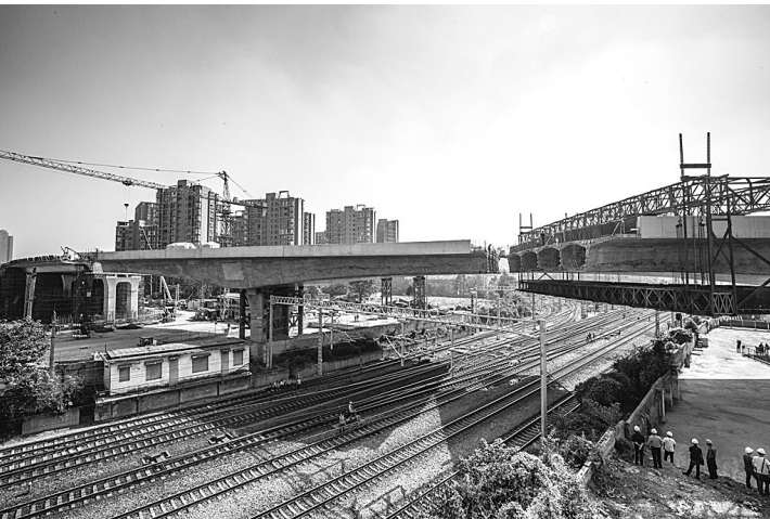
武汉市梅家山立交跨铁路转体桥转体现场。
